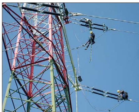
Bild 3: Kontrolle der Armaturen
