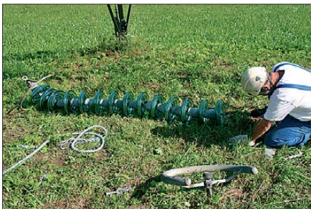
Bild 11: Demontage eines Glaskappenisolators
