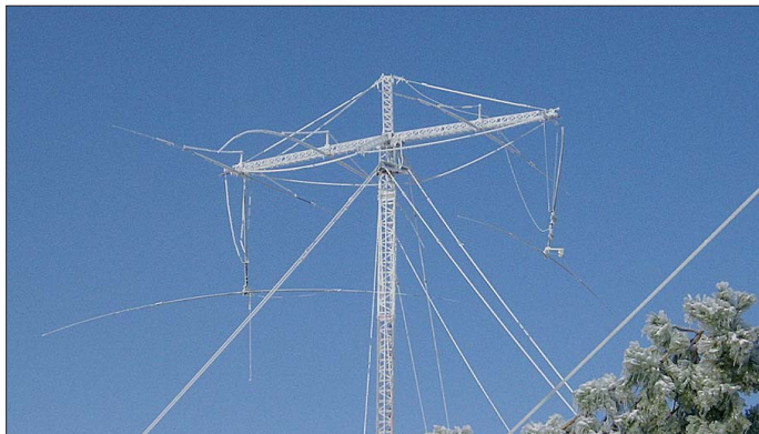
Unter der Eislast im vorigen Winter zusammengebrochen: der Fünfelement-Beam für 40 m auf einem 45-m-Mast bei K5GO, einer bekannten Conteststation im Nordwesten von Arkansas. Inzwischen konnte die Antenne repariert werden.
